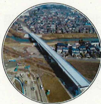
多賀城線橋梁
